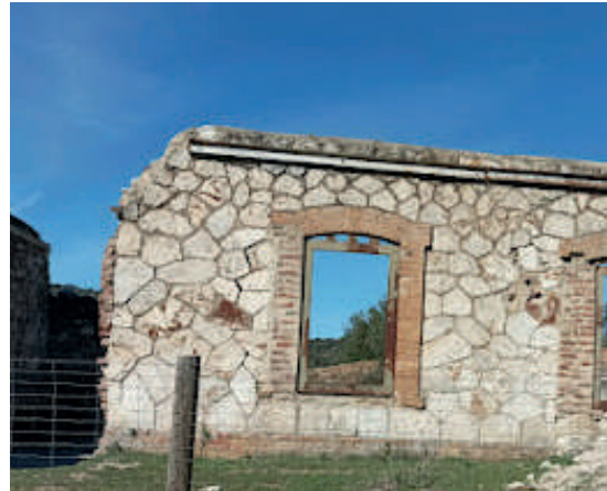
Antigua estación de Cerro del Hierro
