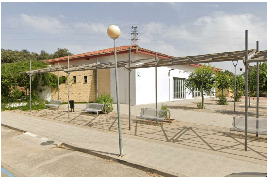
Edificio destinado a sala polivalente o multiusos
