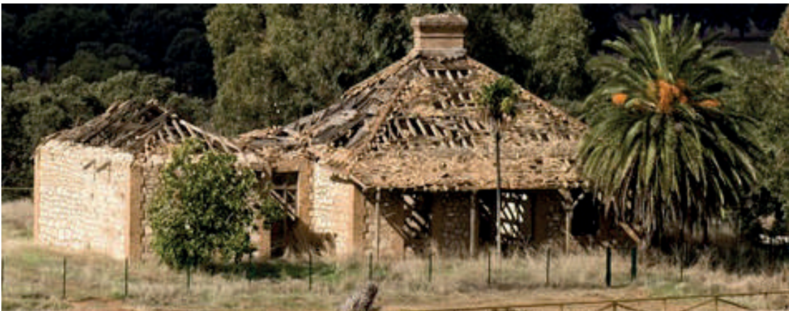
Casas de los ingleses de Cerro del Hierro
