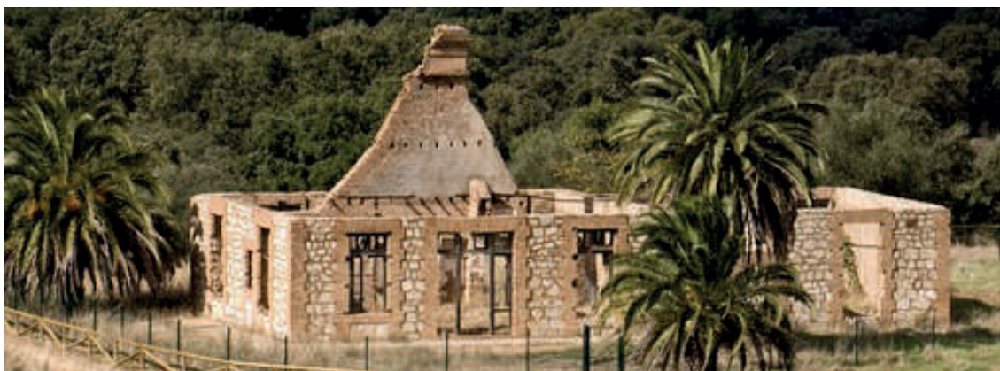
Casas de los ingleses de Cerro del Hierro
